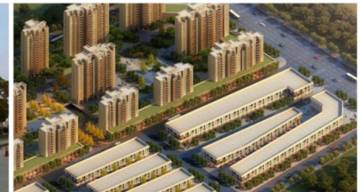
河南省鹤壁市山城区新都汇、澳林城
