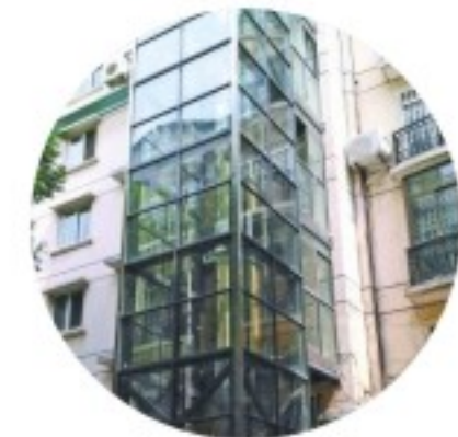
• 加装/改造电梯 External shaft elevator
